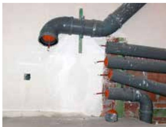
Fig. 2 Il est préférable de réaliser la barrière d'étanchéité à l'air avant la fixation des conduits le long d'un mur extérieur maçonné.
